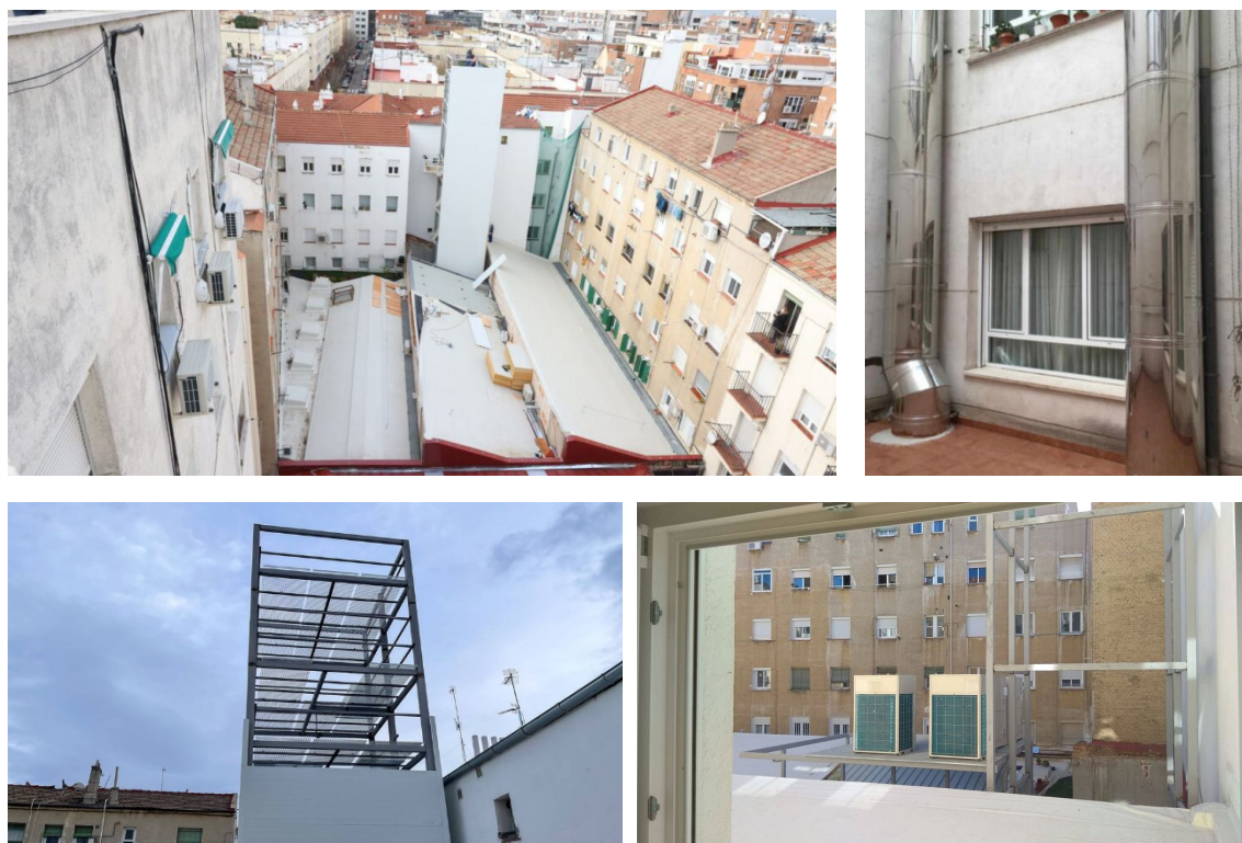
Figura 8. Instal·lacions de la xemeneia industrial d'una dark kitchen al barri de Prosperidad (Madrid).
