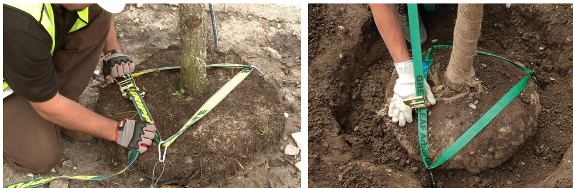
Ancoratges subterranis amb sistema d'eslingues i trinquet
